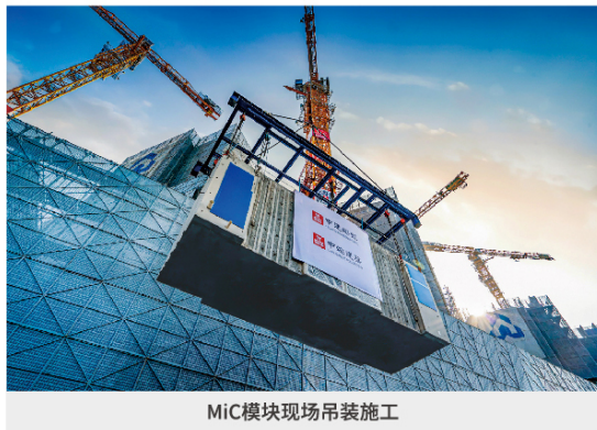
MiC模块现场吊装施工
